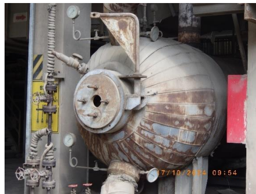
รูปที่ 2-53 Steam Drum ของหม้อไอน้ำ
