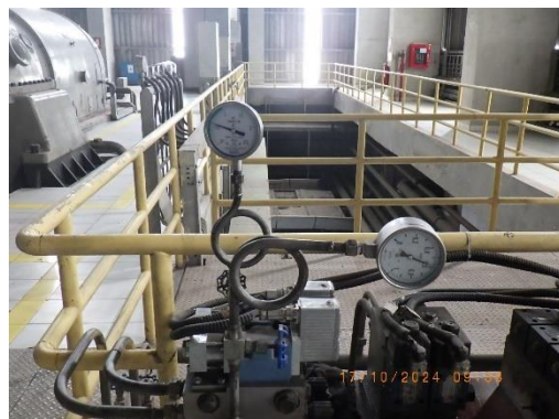
รูปที่ 2-59 Pressure Transmitter ของหม้อไอน้ำ
