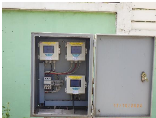
รูปที่ 2-44 ระบบตรวจคุณภาพน้ำอัตโนมัติ
