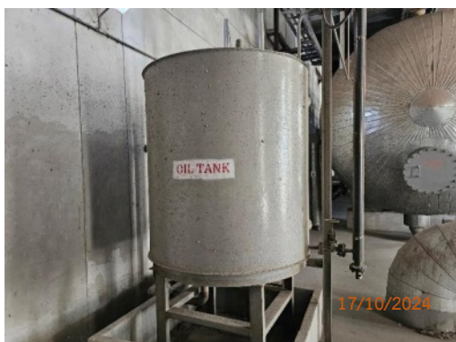
รูปที่ 2-65 Emergency Gravity Oil Tank
