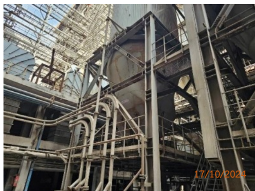
รูปที่ 2-13 ระบบ Limestone Injection
