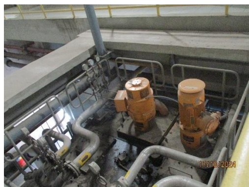
รูปที่ 2-66 DC Oil Pump ภายในโรงไฟฟ้า
