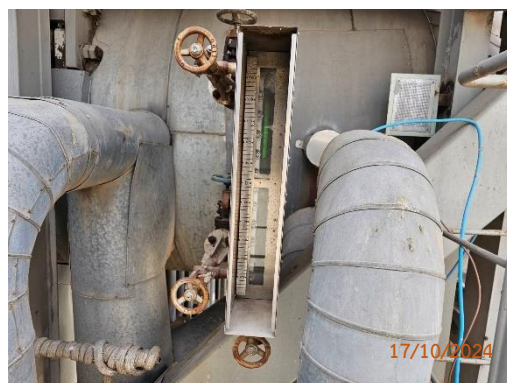
รูปที่ 2-61 เครื่องวัดระดับน้ำของหม้อไอน้ำ
