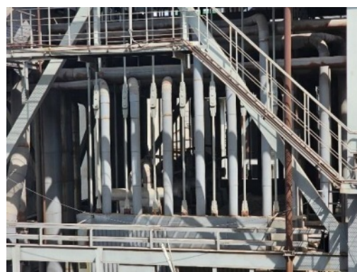
รูปที่ 2-57 Rapid Drain Piping System ของหม้อไอน้ำ
