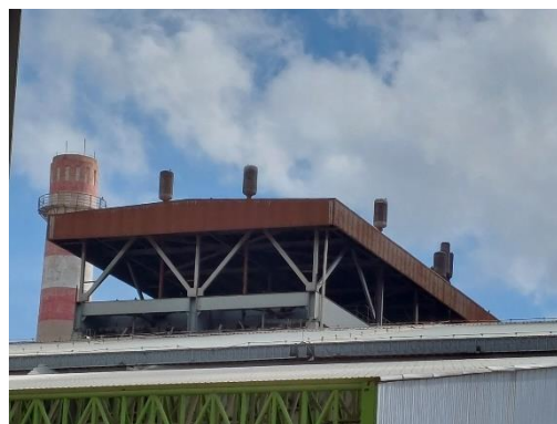
รูปที่ 2-20 ชุดลดเสียง (Silencer)
