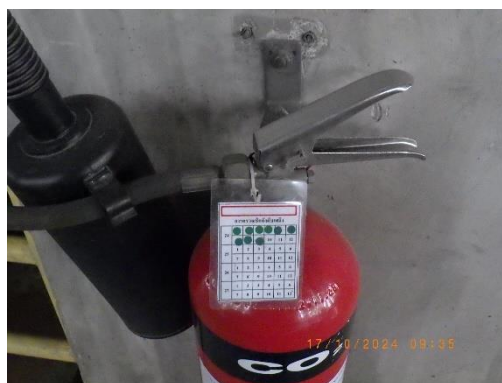
รูปที่ 2-51 การตรวจถังดับเพลิง
