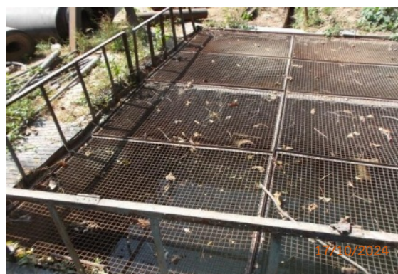
รูปที่ 2-69 ตะแกรงบริเวณสถานีสูบน้ำของโครงการ
