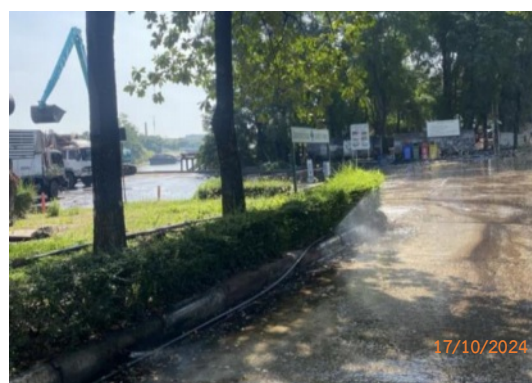
รูปที่ 2-37 ระบบการพ่นละอองน้ำเพื่อป้องกันการฟุ้งกระจายของถ่านหิน
