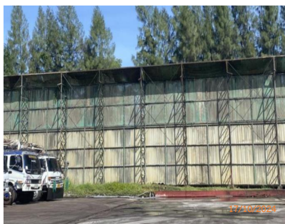
รูปที่ 2-38 การติดตั้งตาข่ายกันฝุ่นละออง
